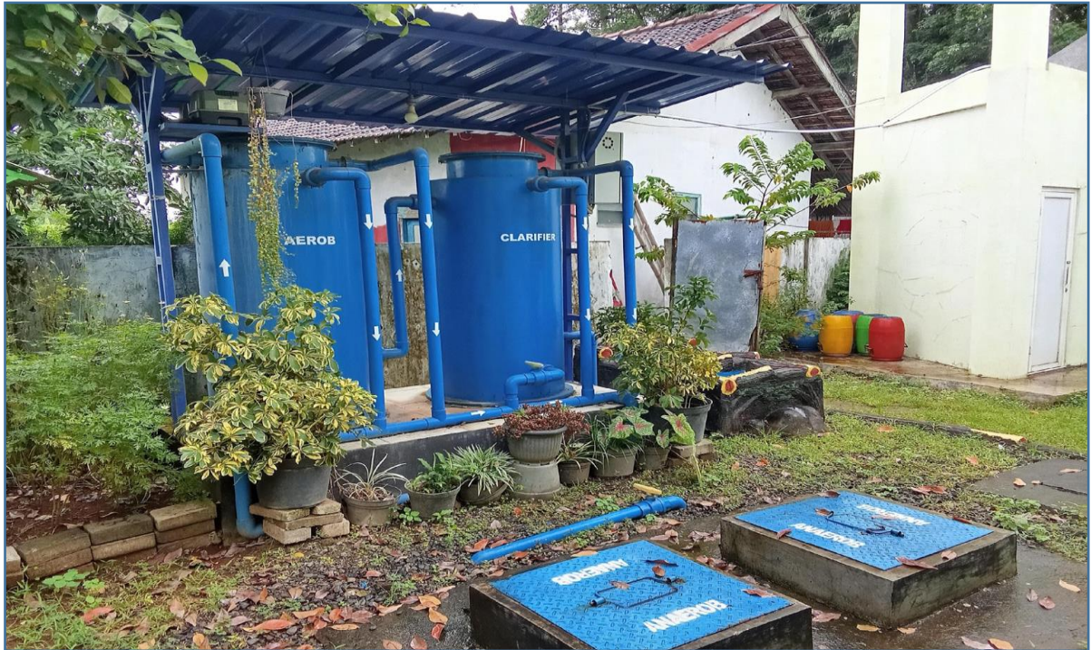
Gambar 3.11 Instalasi Pengolahan Limbah Cair UPTD Puskesmas Pati II
